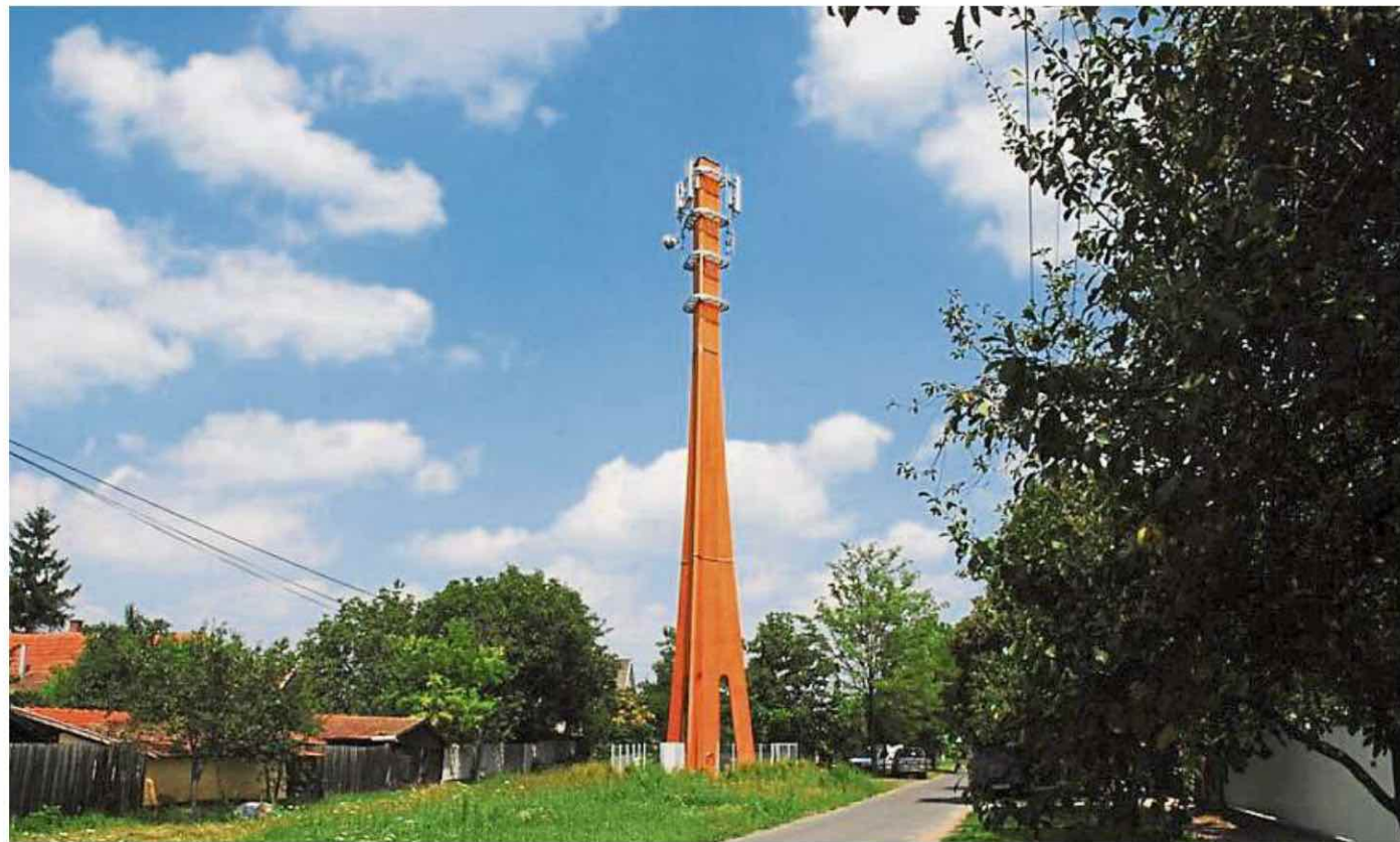
So könnte der geplante Mobilfunkmast in Bechtolsheim einmal aussehen. Die neuartige Holzkonstruktion kam bisher in Deutschland in dieser Form noch nicht zum Einsatz.
