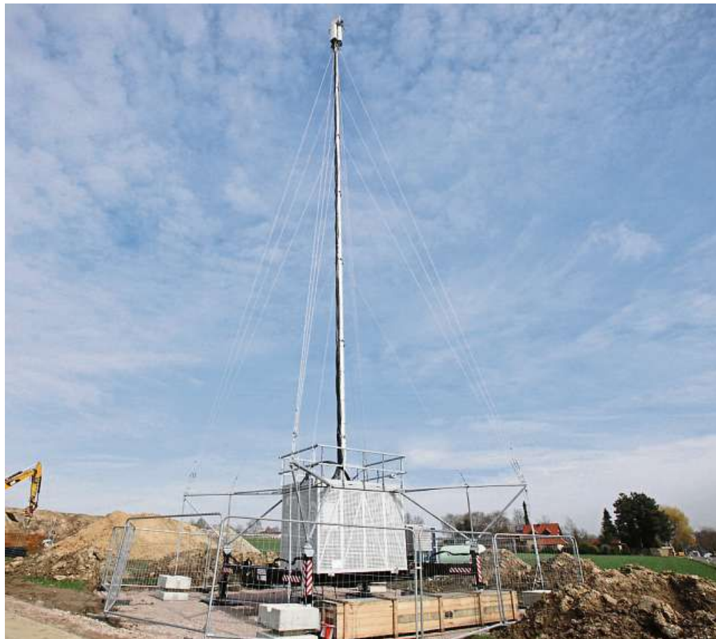
Der mobile Funkmast am Ortsrand von Bechtolsheim steht – allerdings ist er aktuell nicht für alle Mobilfunkkunden nutzbar.
